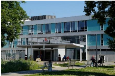
Stauferklinikum Mutlangen Wetzgauer Straße 85 73557 Mutlangen
